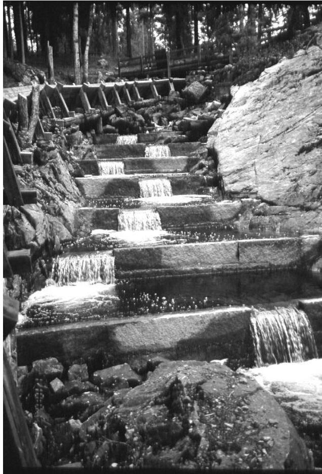
Bassängtrappa i natursten. Valån, Nissans vattensystem.
