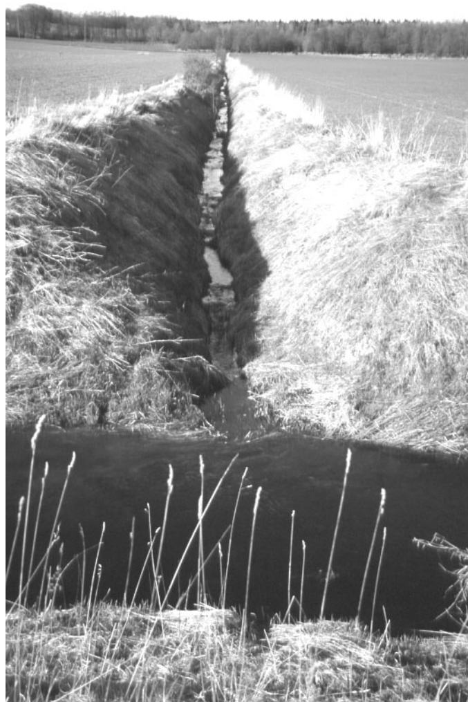
Dike i jordbruksmark som helt saknar skydds- och översilningszon
